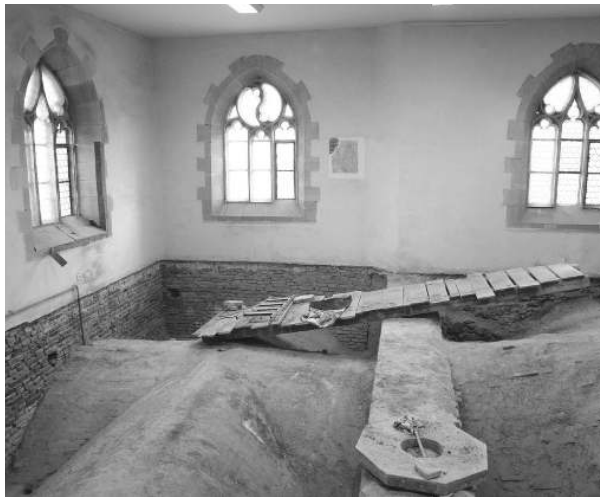
Aus der Stadtpfarrloge über der Sakristei mussten wegen Pilzbefall über 40 m 3 Bauschutt entfernt werden, um die Gewölbe freizulegen.
