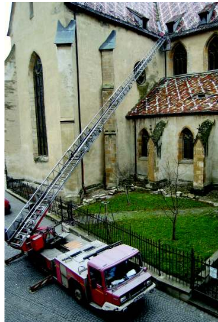
Immer wieder Feuerwehreinsätze: Reparaturen am Kirchendach
