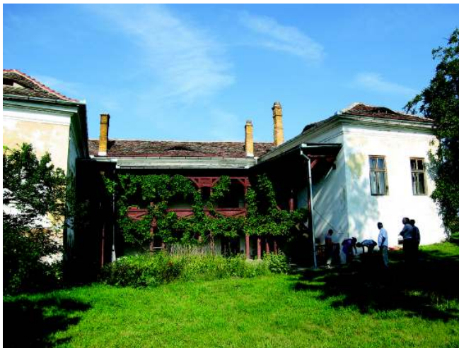
Pfarrhaus Schellenberg: hier entsteht ein Zentrum für Betreutes Wohnen
