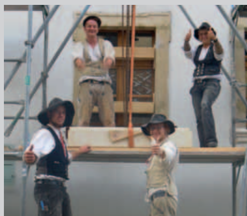
Drei neue Fensterbänke haben die Wandergesellen nach Plänen von Architekt H. Fabini gefertigt und in die Fassade des Pfarrhauses eingesetzt.
