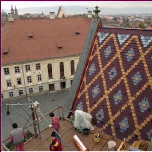
Kirchenbaustelle: Die ersten Ziegel der neuen Dachdeckung sind sichtbar.
