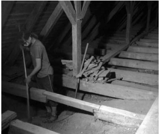
Die Lausitzer Jugendgruppe räumte zwei Container Bauschutt vom Kirchendachboden
